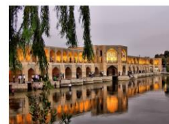
МОСТ КХАДЖУ (ИРАН)
