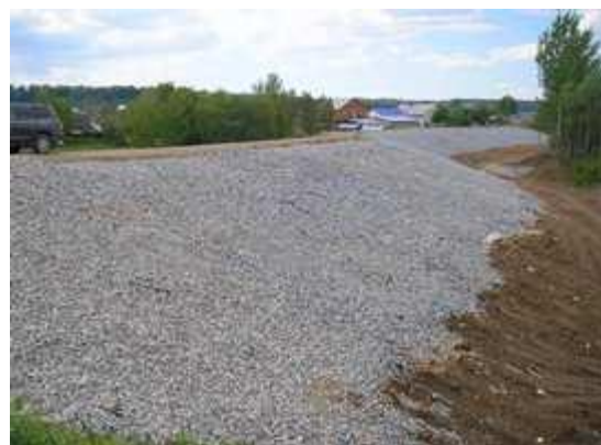
Рис. 14. Подсыпка дамбы на реке Ирень [33]
